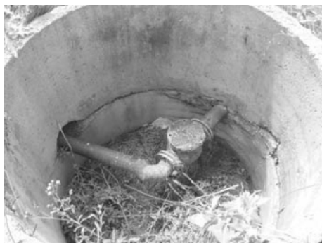
Водопровідний коло- дязь у незадовільному стані (не перекритий)
