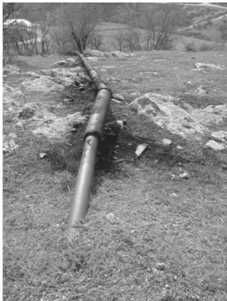
На поверхні землі прокладено не утепле- ний водогін
